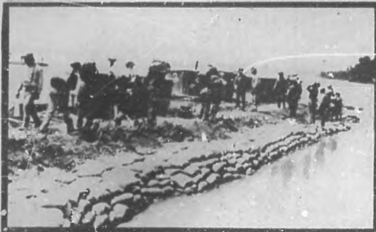
Una vista de los trabajos realizados en Vicksburg para reforzar con sacos el dique del río, a fin de salvar el material ferroviario allí detenido.
